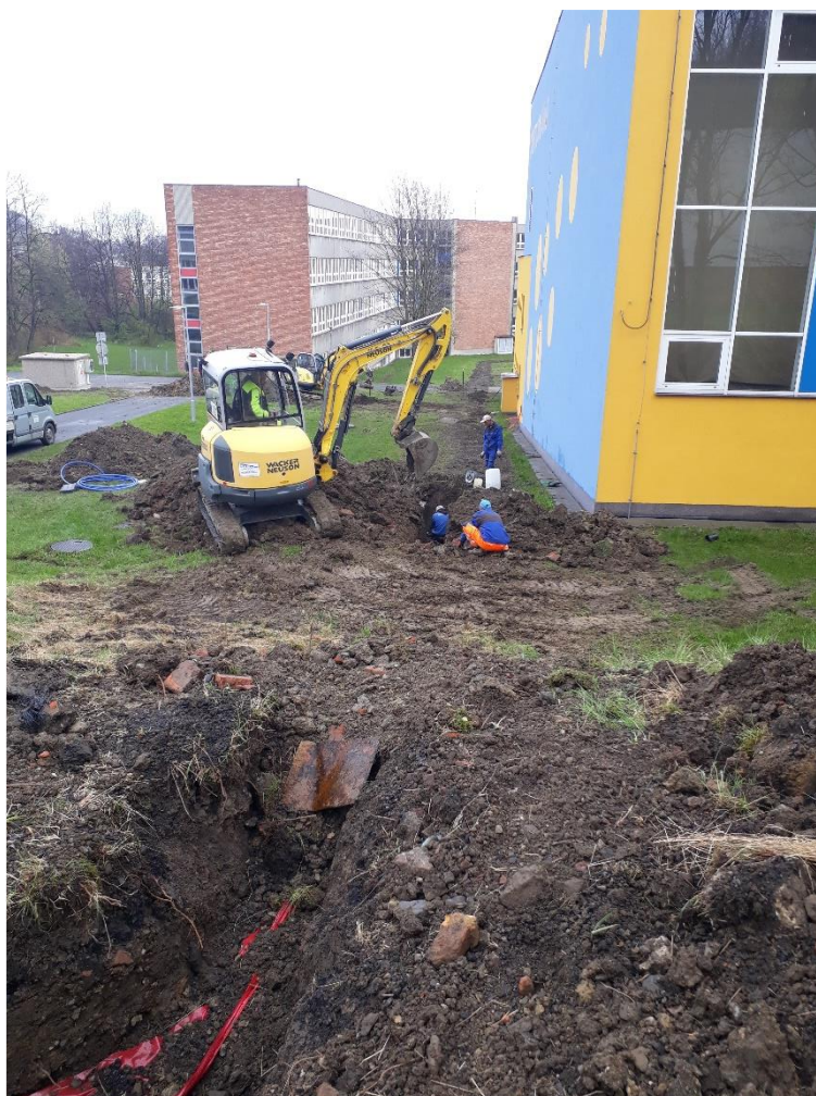
Kopání vodovodní přípojky
