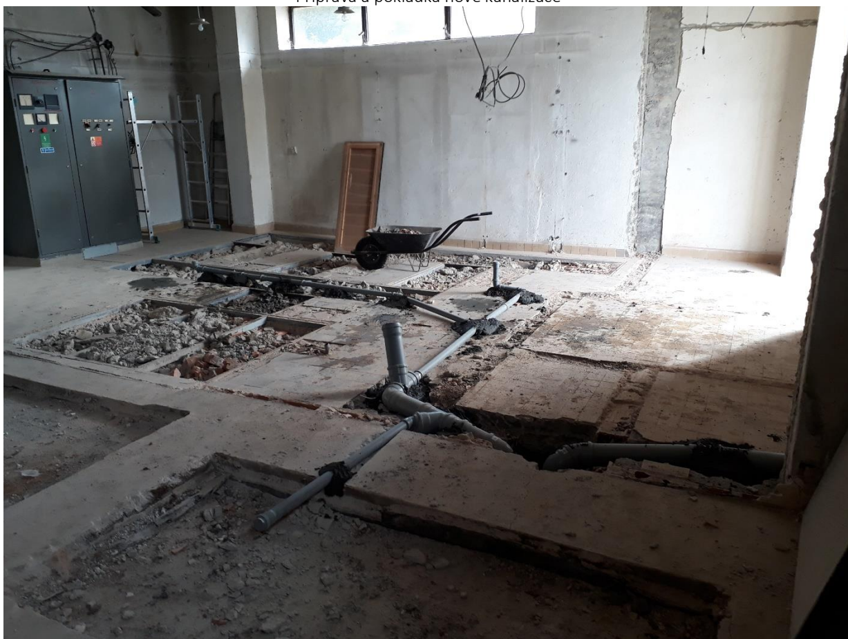
Příprava a pokládka nové kanalizace
