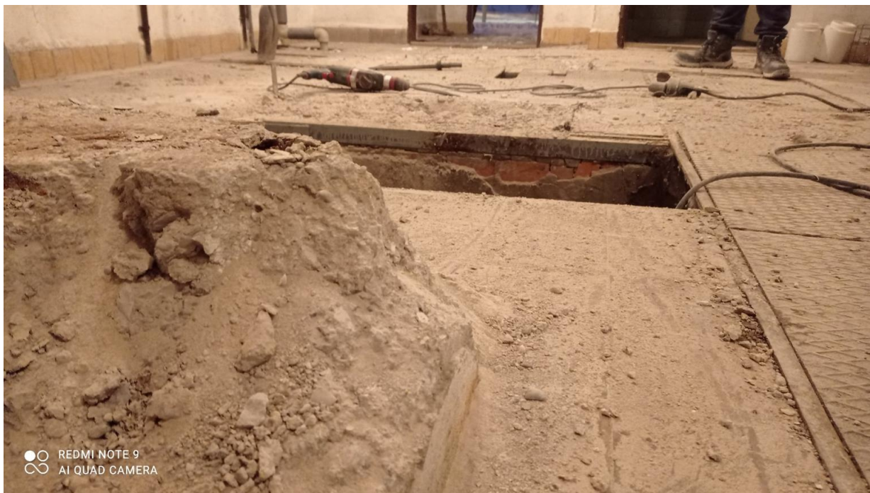
Bourání betonových patek ↑
