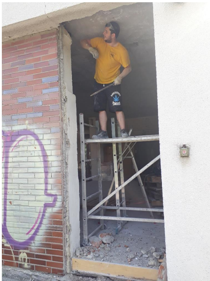
Demontáž původních ocelových profilů
