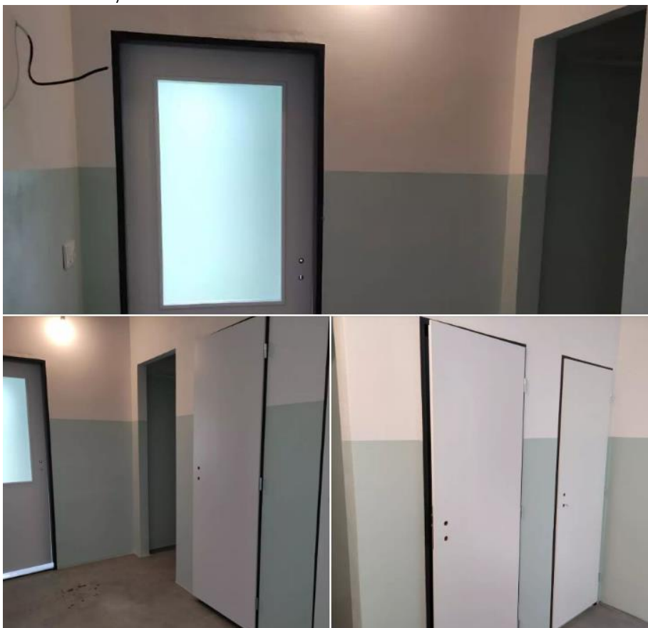
Instalace nových dveří 16. září.
