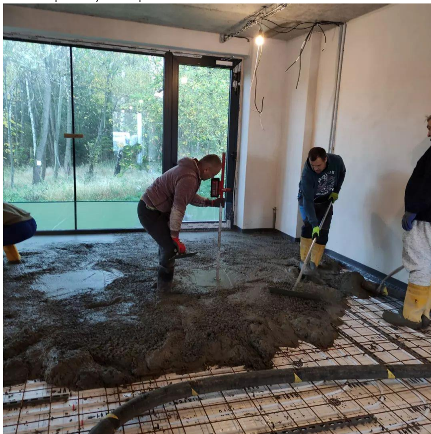
Betonáž podlahy v listopadu.
